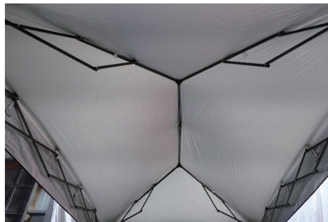
Fig. 5 - Telaio del tetto espanso (vista parziale dall'interno)
