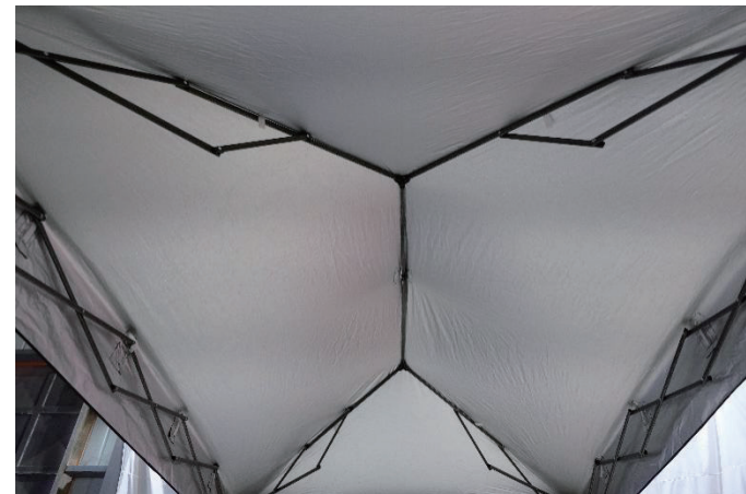
Abb. 5 - Dachrahmen im ausgebauten Zustand (Teilansicht von innen)
